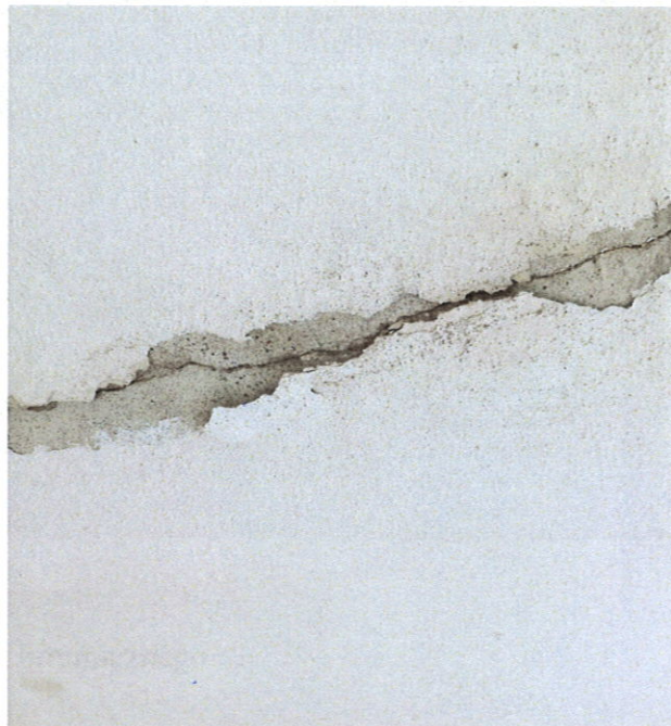
Zdjęcie spękań spodu płyty żelbetonowej
