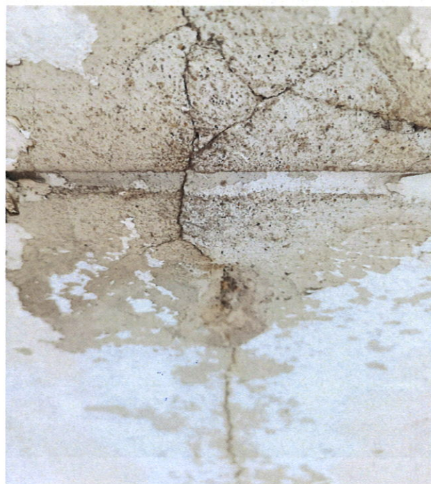
Zdjęcie odkrywki pokrycia bitumicznego
