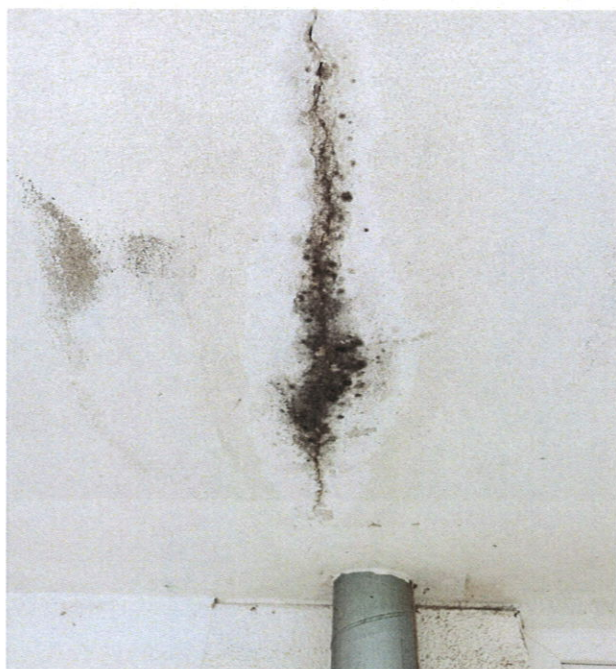
Zdjęcie spękań spodu płyty żelbetonowej
