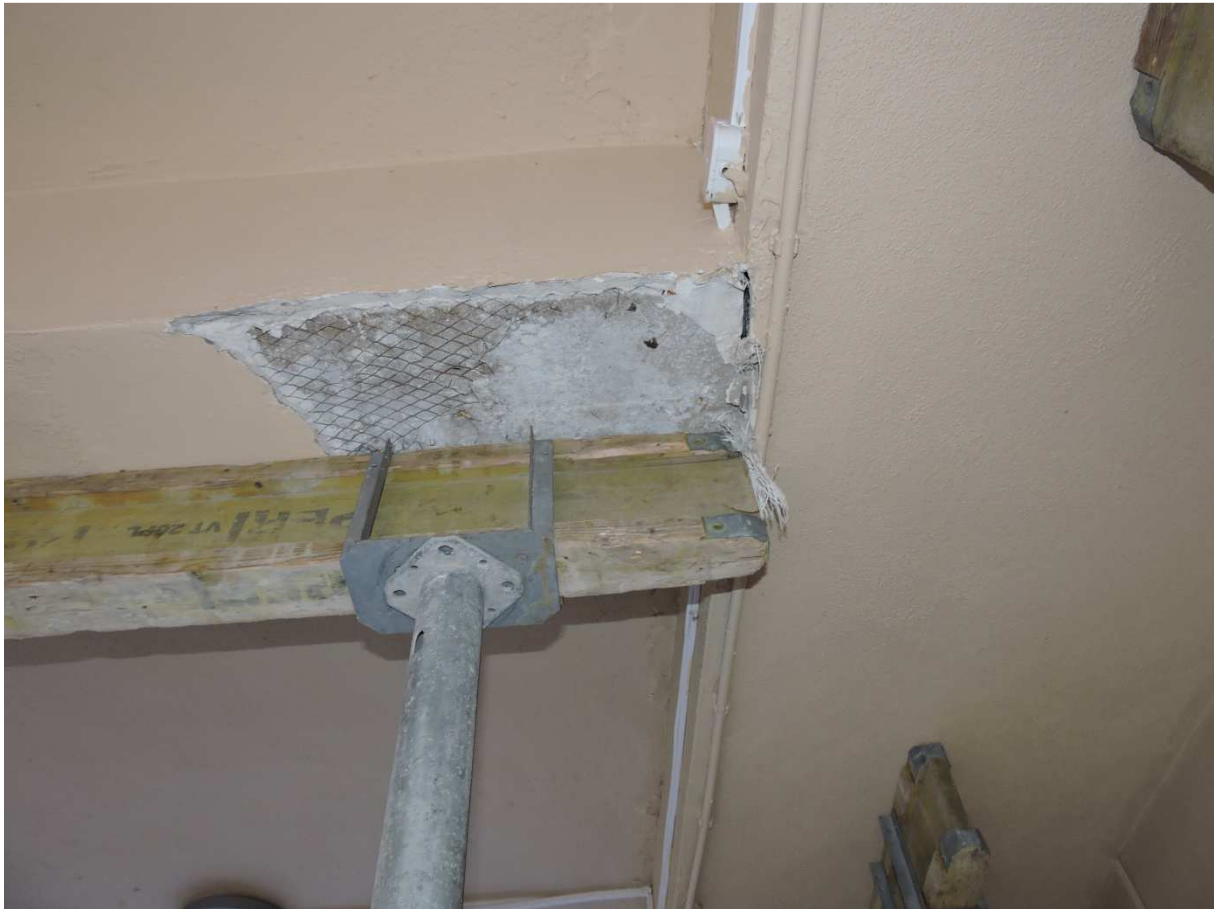
Zdj.7 - widoczne ubytki tynku w strefie dolnej podciągu (ściana północna)
