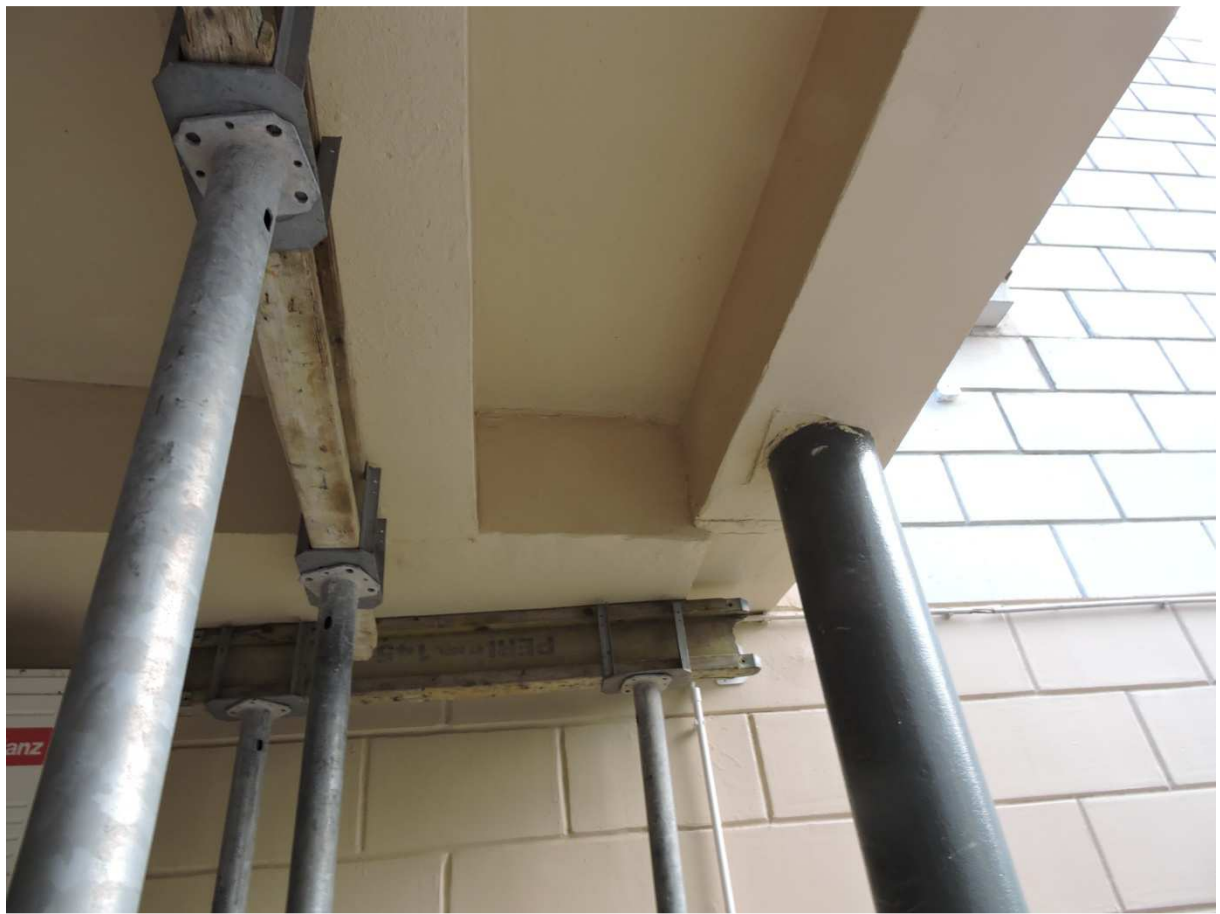
Zdj.12- narożnik północno-zachodni
