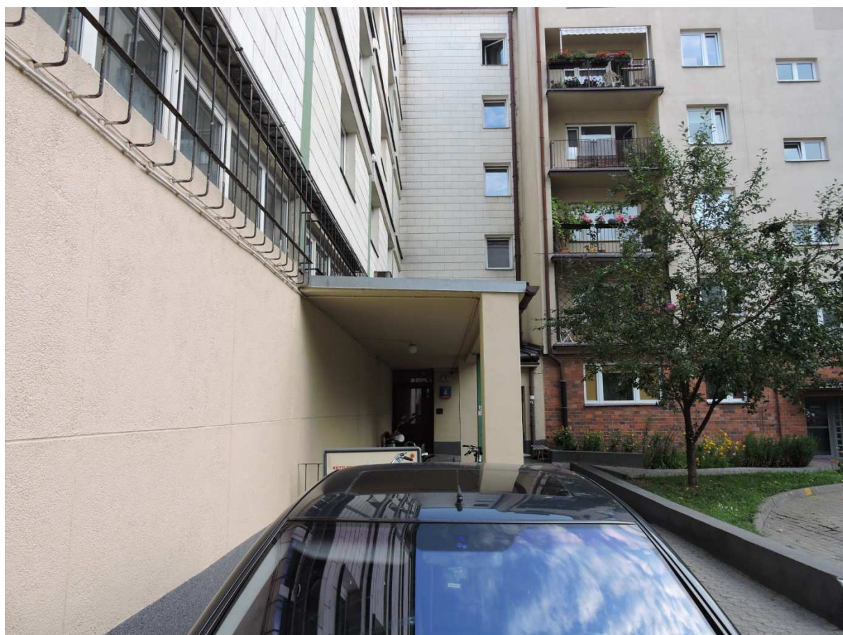
Zdj.6 - widok zadaszenia od strony południowej
