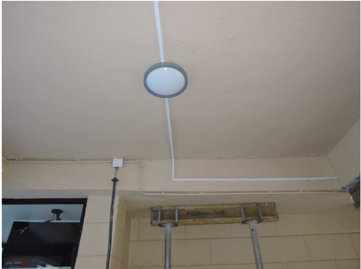
Zdj.6- zdylatowanie się płyty stropodachu ze ścianą północną
