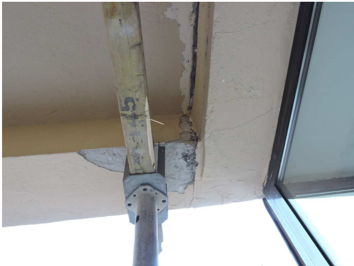
Zdj.3 - widok uszkodzeń w narożniku północno-zachodnim
