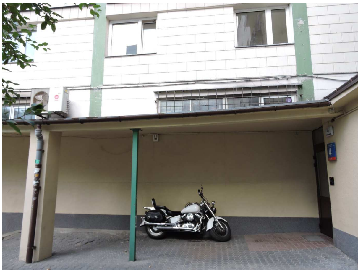
Zdj.3 - widoczne ugięcie w narożniku północno-wschodnim
