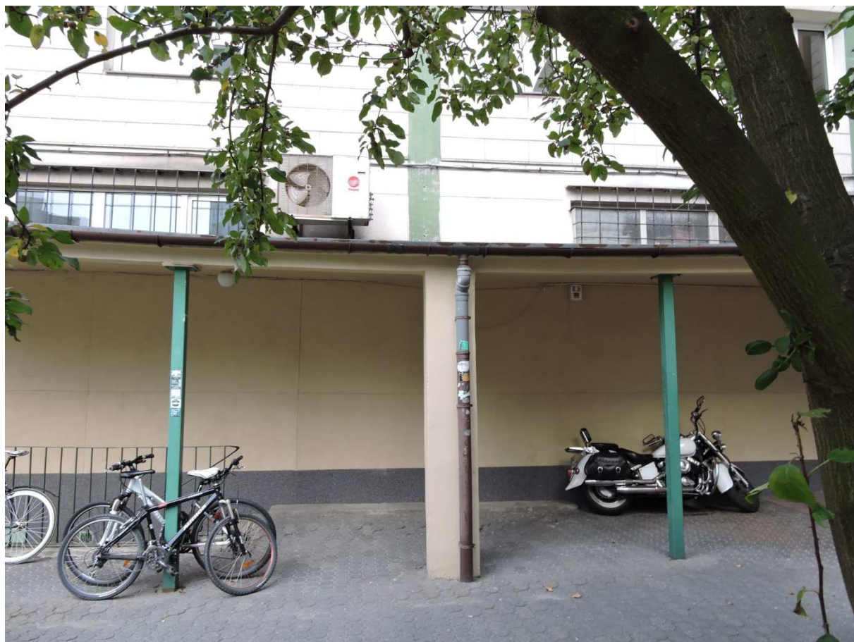
Zdj.4 - widok zadaszenia w części środkowej
