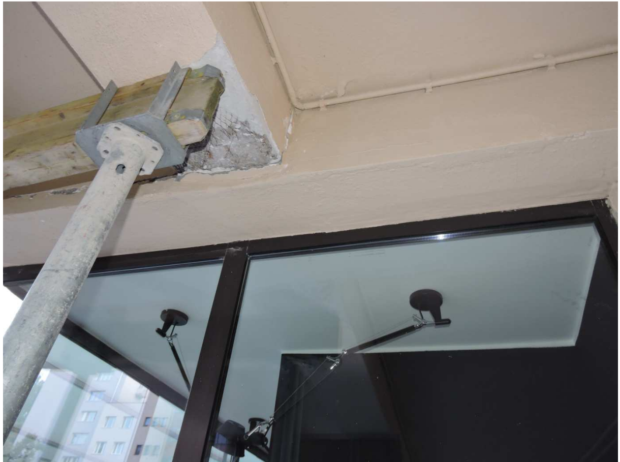
Zdj.5 - widoczne uszkodzenia podciągu w narożniku północno - zachodnim
