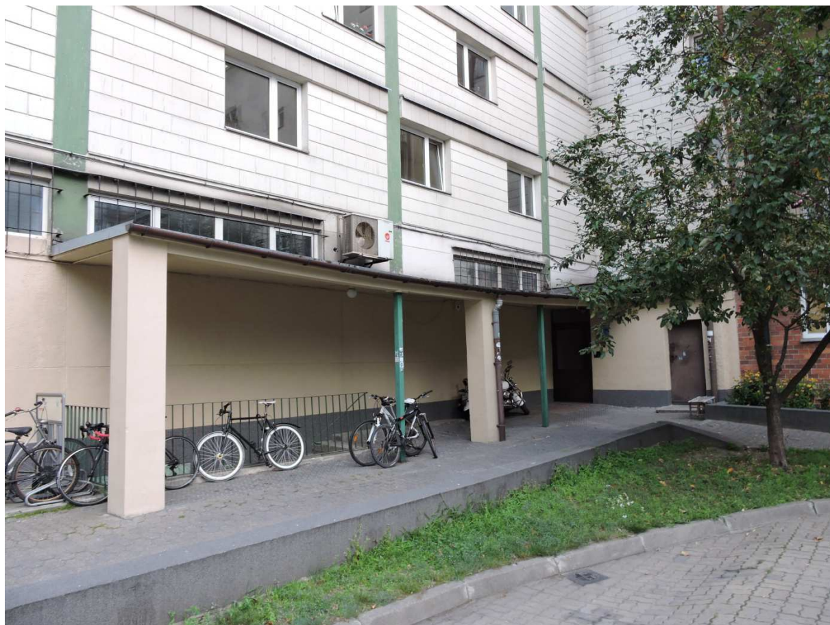
Zdj.5 - widoczne ugięcie płyty zadaszania część południowo-wschodnia
