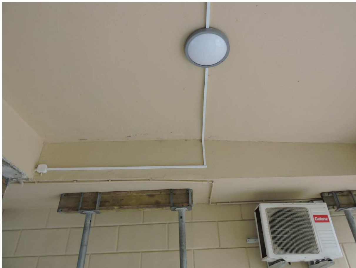
Zdj.9 - część środkowa ściany północnej
