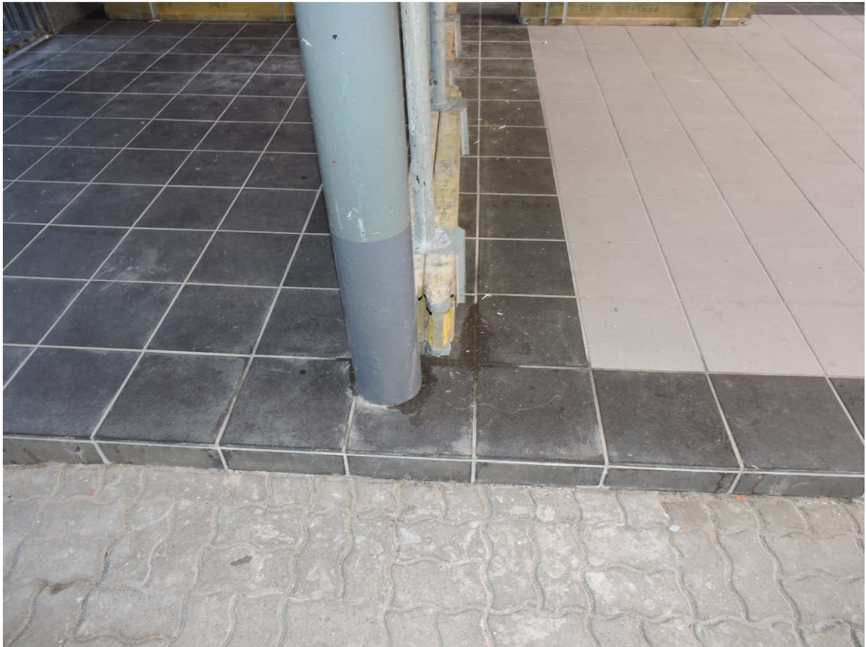
Zdj.8-strefa posadzki w narożniku północno - zachodnim
