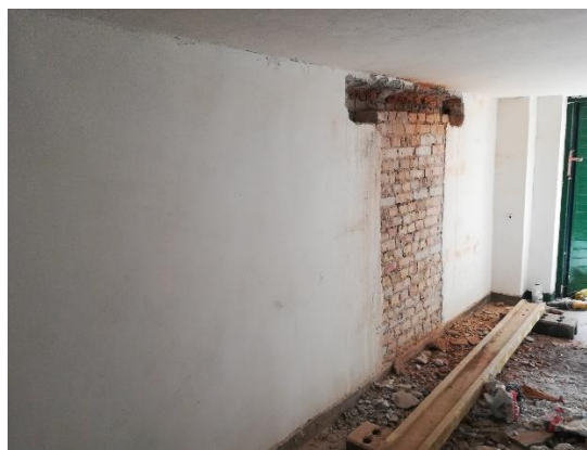
Wykucia pod nowe drzwi do rowerowni
